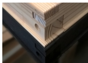
Assemblage à enfourchement
